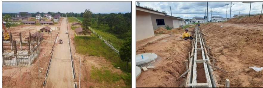
รูปที่ 1-19 ความก้าวหน้าการก่อสร้างงานรางระบายน้ำ
