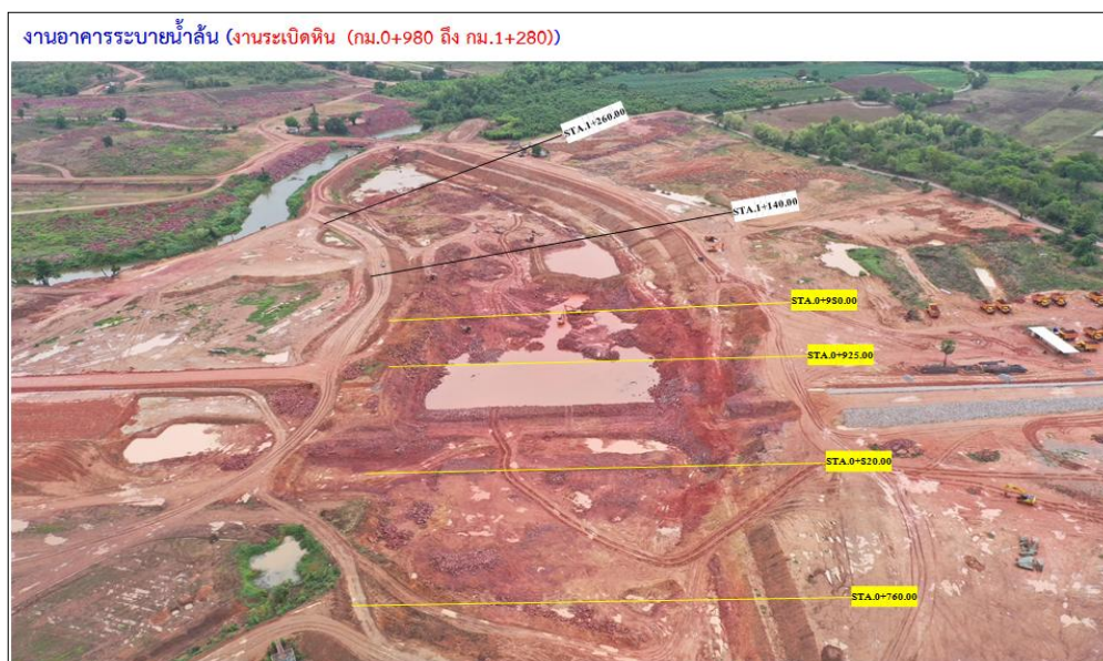
รูปที่ 1-5 ความก้าวหน้าการก่อสร้างงานอาคารทางระบายน้ำล้น
